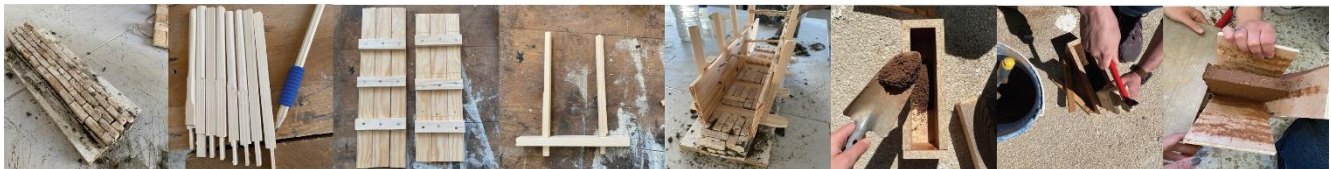
Mas La Crau (83) - Chaîne opératoire 1 : de la matière (terre) au matériau (argile tamisée) ; Chaîne opératoire 2 : du matériau (argile tamisée) à l'édifice (mur). L. Fasquel, A. Alhilwani, ©LMdP2023.
