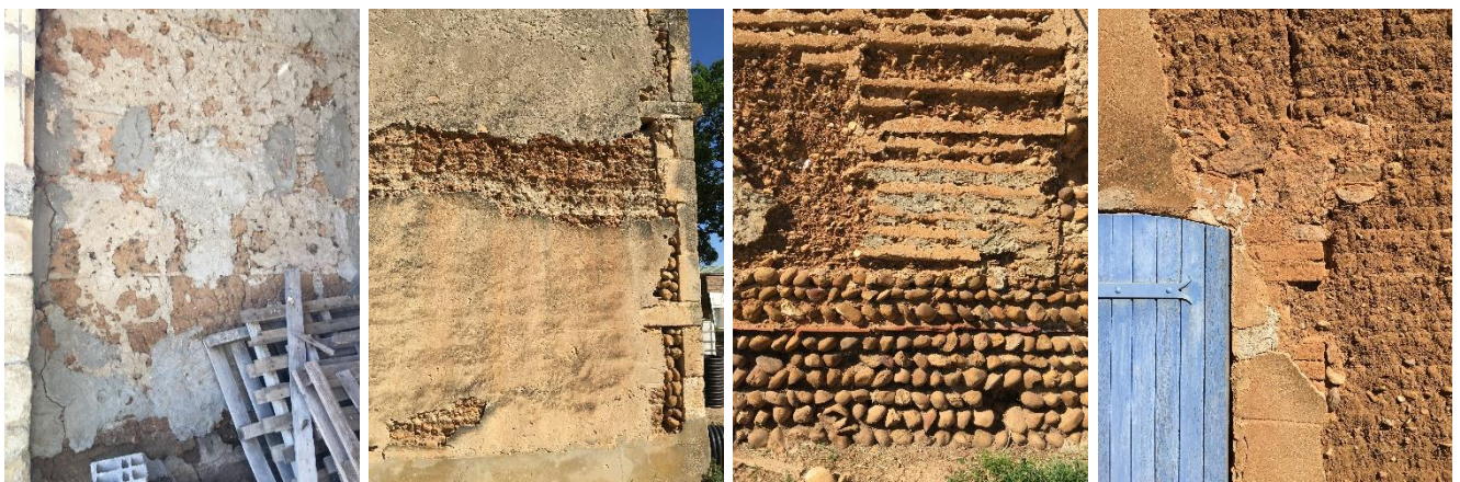
Tapie dans la plaine de la Crau (13) (1, 2, 3) et à La Crau (83) (4) : Différentes mises en œuvre du pisé. C. Silvestri, C. Marchiaro, ©LMdP2023-24.
