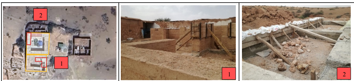
Figure 2: Chantiers de reconstruction écologique à Imi N'Ouassif (Assif El Mal) – Septembre 2024
