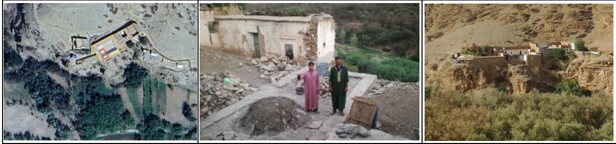
Figure 3: Chantier de reconstruction à Imighzer (Assif El Mal) – Septembre 2024
