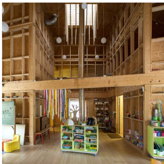
Figure 12: La ruche de Tendon : vue intérieure de la structure en hêtre, Haha architecture, 2024 (© Mathiotte, DRAC Grand Est).
