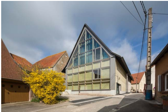
Figure 3: La Villa de Dehlingen : mur Trombe de la façade sud, Nunc architectes, 2015 (© Boegly, DRAC Grand Est).
