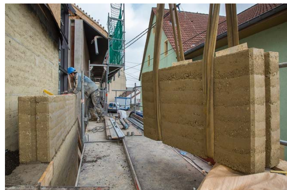
Figure 25: La Villa de Dehlingen : vue du chantier de construction, 2014 (© Meyer).
