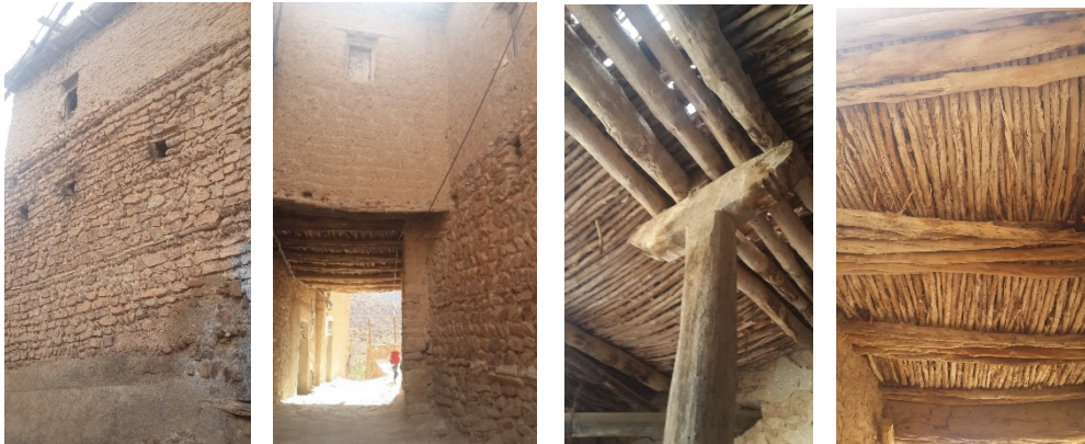
Figure 2 : Habitations en terre, techniques de construction vernaculaire, Menâa (Batna)
